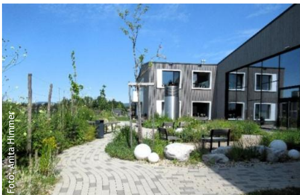
Begegnungszone und naturnahe Gestaltung gehen hier beim Haus der Senioren in Henndorf am Wallersee Hand in Hand.
